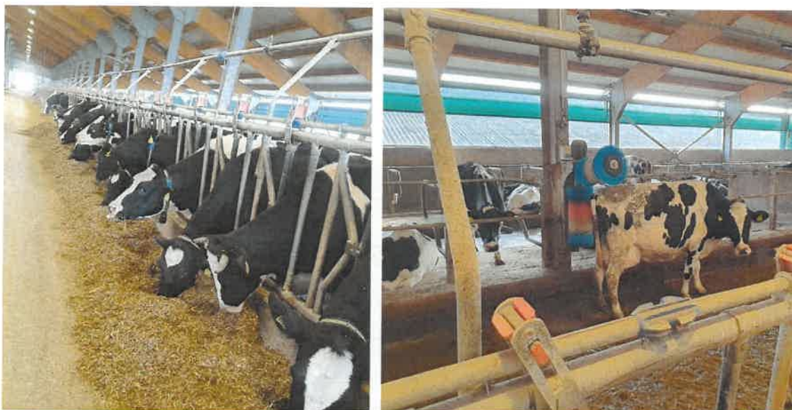
Figura 4. Imagini din adăpost vaci lapte. Adăpostul este prevăzut cu un sistem automat de sprinklere pentru combaterea stresului termic
